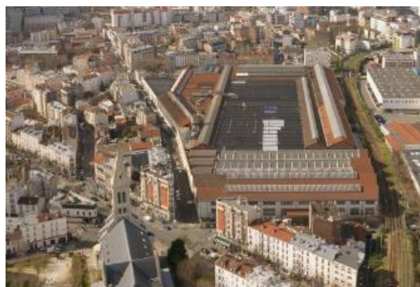
Usine état ACTUEL – vue d'ensemble
